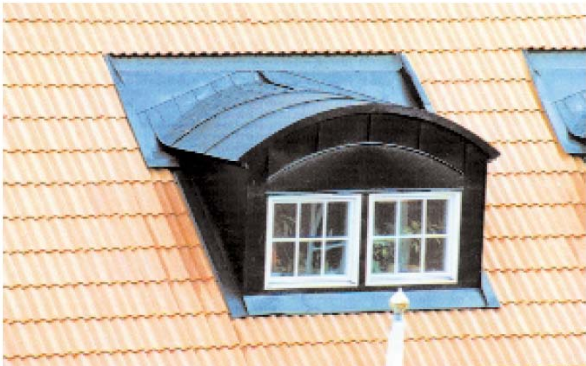
obramowanie okna mansardowego zintegrowane z płytkami pokrycia
