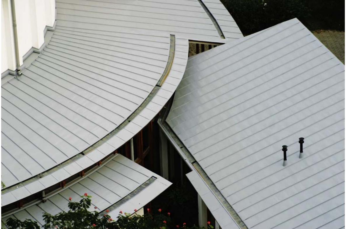
Krycie dachu blachą PLX
