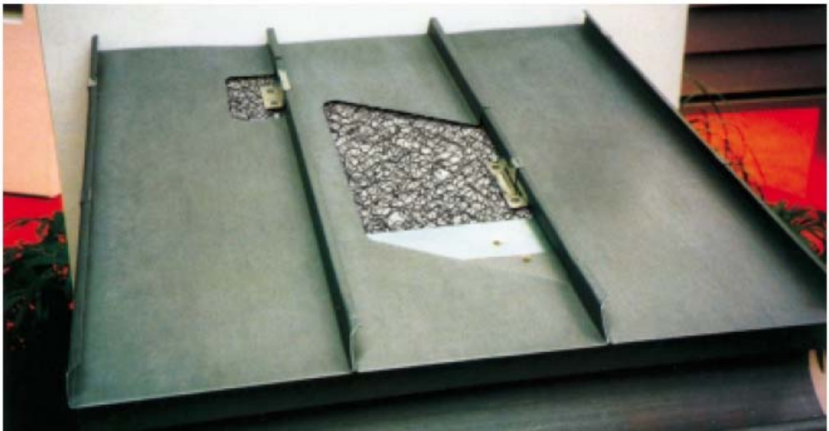
pokrycie dachowe z blachy PLX z niedużym kątem nachylenia połaci i poduszką powietrzną jako warstwą rozdzielającą
